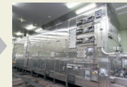
④連続スチーマーで加熱殺菌と冷却を行い、箱詰めされ出荷されます。
