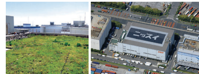
屋上緑化により断熱性が向上、省エネにも寄与(川崎物流センター)(左) 屋上に設置した太陽光パネル(東京物流センター)(右)
