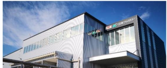
日本クッカーリー(株)伊勢崎工場 2019年1月から稼働
